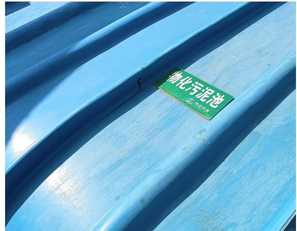
污水处理站（污泥池）
