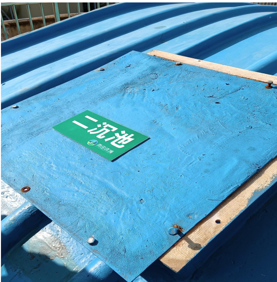
污水处理站（二沉池）
