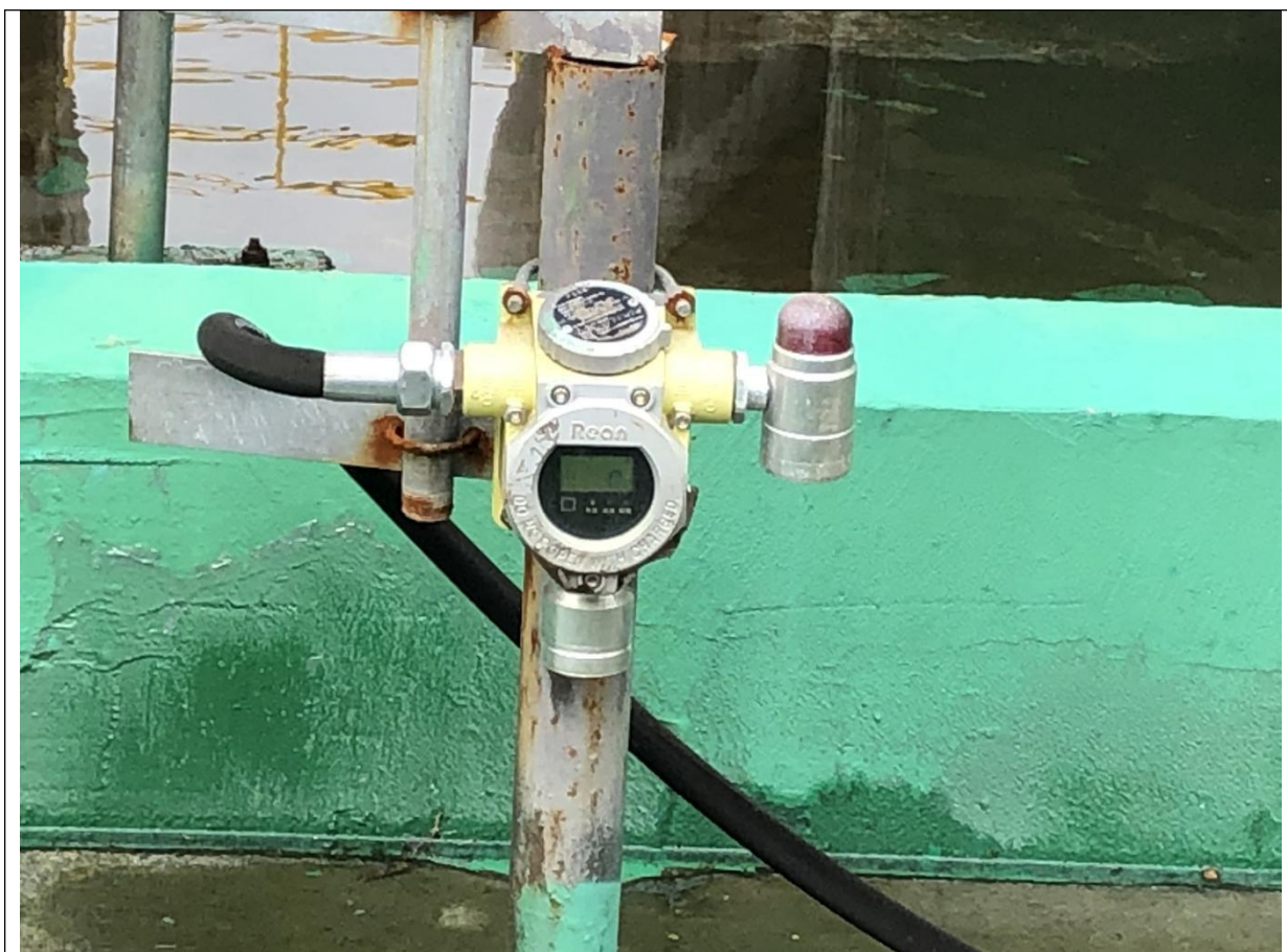
罐区及围堰图片
